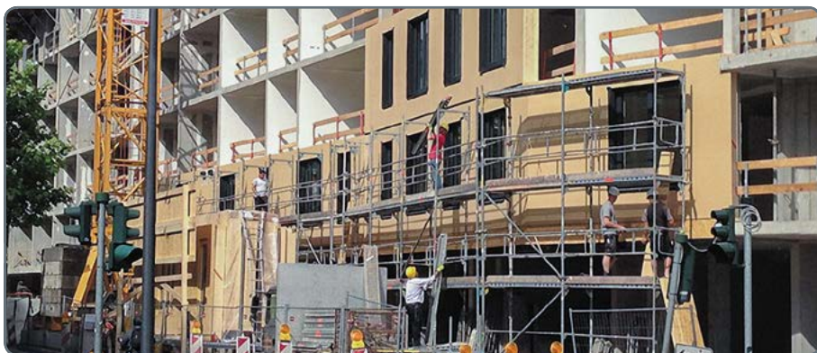
■ ЭТАП МОНТАЖА НАРУЖНЫХ СТЕНОВЫХ ДЕРЕВЯННЫХ ПАНЕЛЕЙ ■
