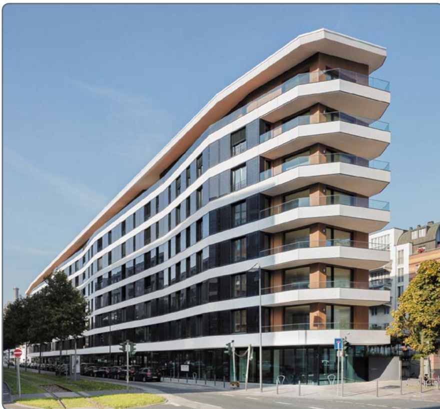
ЮЖНЫЙ ФАСАД ЗДАНИЯ
